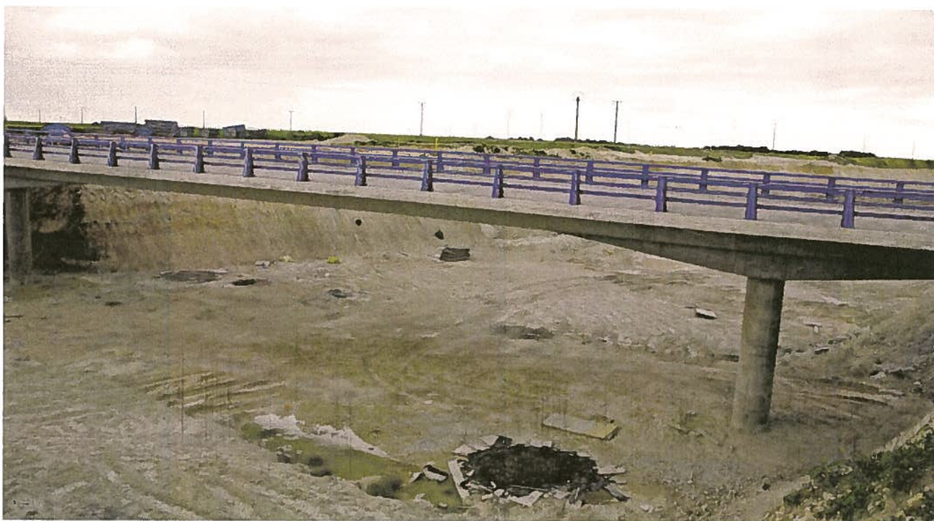
Obras de la autovía de Valladolid, en el término de Villanubla. Gabriel Villamil
