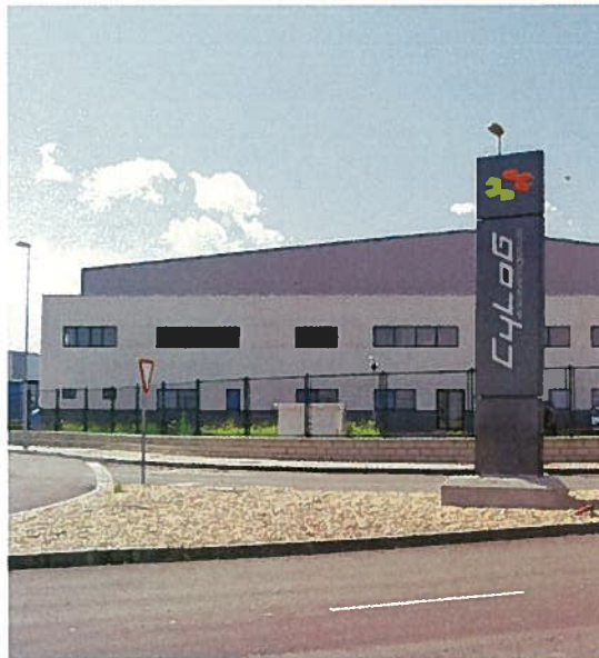
Oficina central del centro de transportes de León (CETE)
