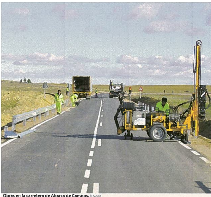
Obras en la carretera de Abarca de Campos. El Norte
