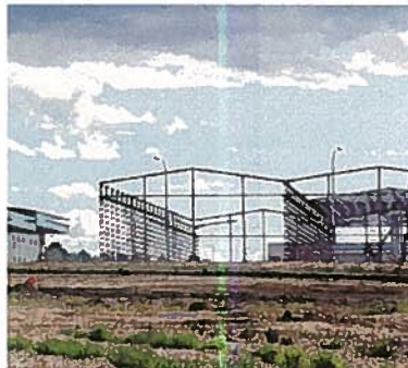
Obras de construcción de naves industriales en el polígono de Navalcaballo. Luis Ángel Tejedor/Heraldo
